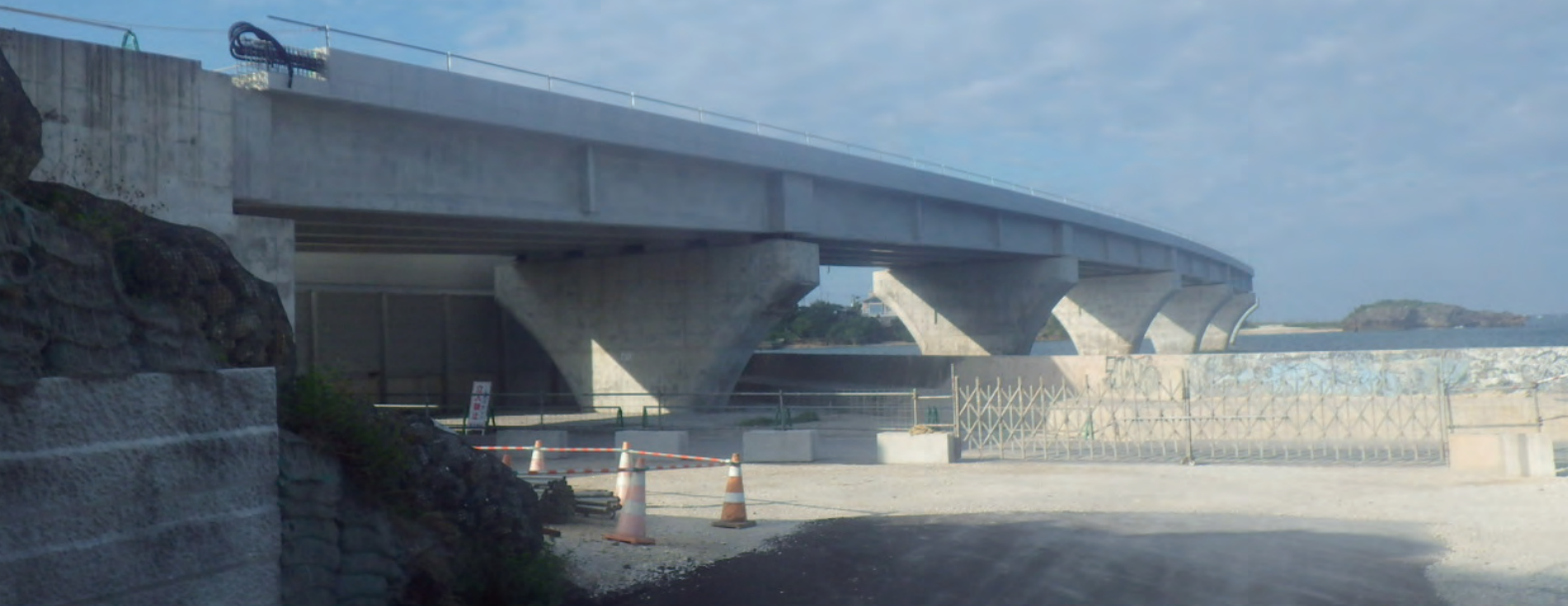
那覇大橋仮棧橋設置工事(25-1工区)／沖縄県
