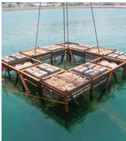
鉄骨スラグを組み込んだ「藻場礁」を水深6メートルに沈設し、モニタリング調査を行う。
