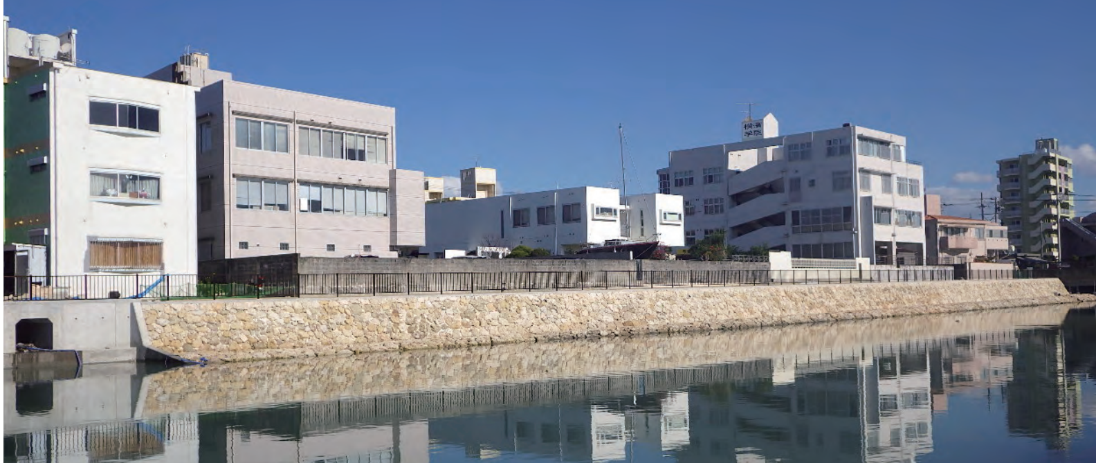
(仮称)北中城村アワセ土地区画整理事業 株竹中土木・株國場組・株仲本工業JV／北中城村アワセ土地区画整理組合
