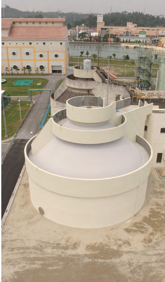
具志川浄化センター3号汚泥消化タンク築造工事／沖縄県 平成28年度沖縄県知事表彰(2016年)
