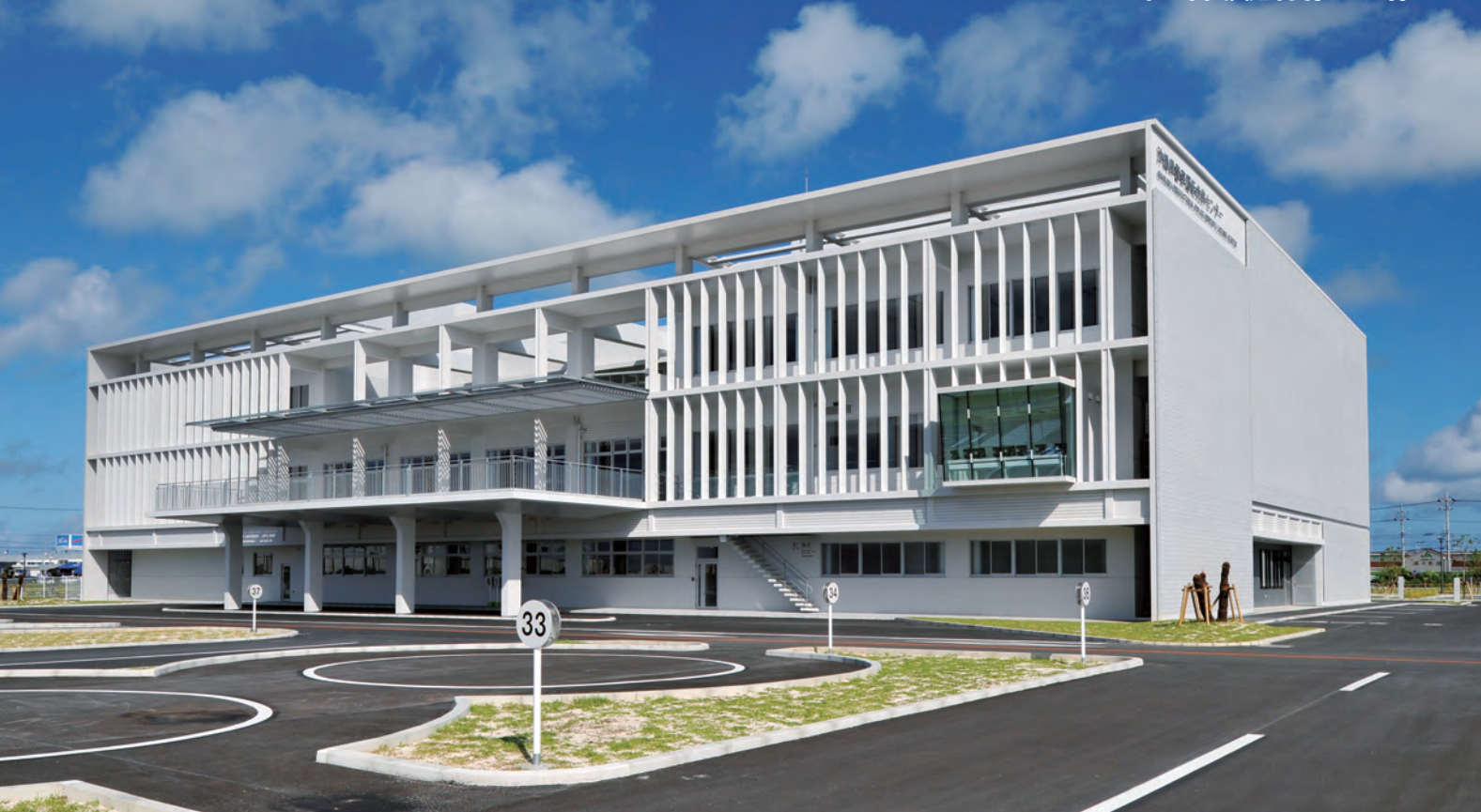
沖縄県口腔保健医療センター新築工事
