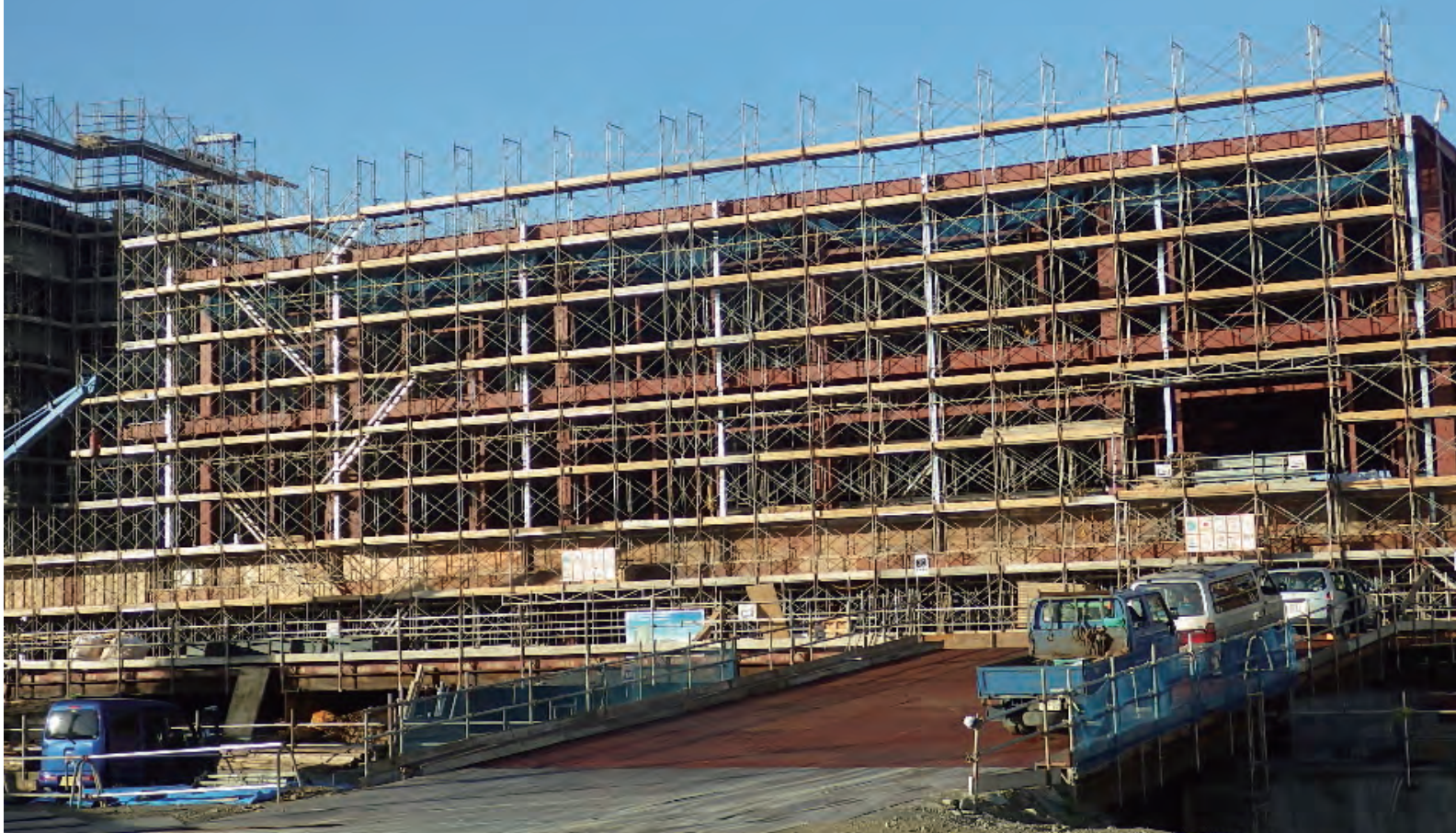
沖縄県立高度・多機能病院(仮称)新築工事(1工区・3工区)(鉄骨工事)
