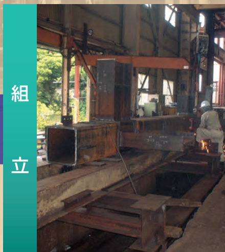
■柱大組立 組立図通りに組み立て仮溶接をする
