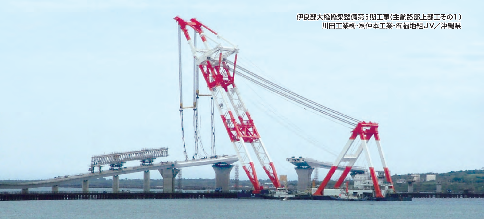
伊良部大橋橋梁整備第5期工事(主航路部上部工その1) 川田工業(株)・(株)仲本工業・(有)福地組JV／沖縄県
