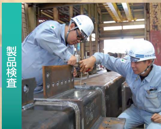
■寸法精度確認及び非破壊検査 欠陥がないよう、厳正な検査を行う
