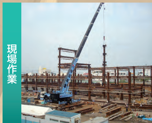
■建て方 工事現場にて鉄骨を組み立てていく
