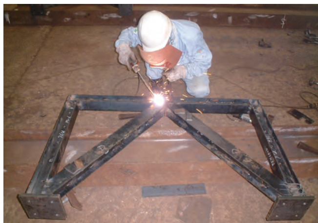
弊社工場にてブレース製作
