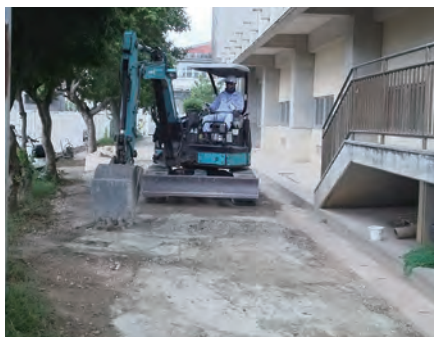
美原小学校敷地整備
