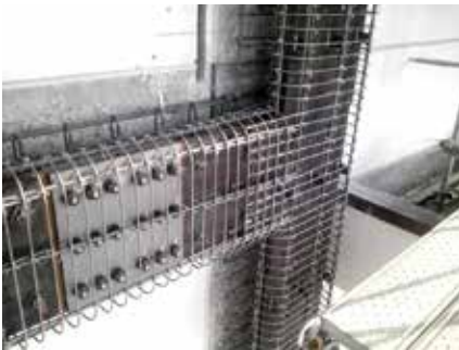
ブレースタイプ 補強体がブレースタイプの完全外付け工法です。
