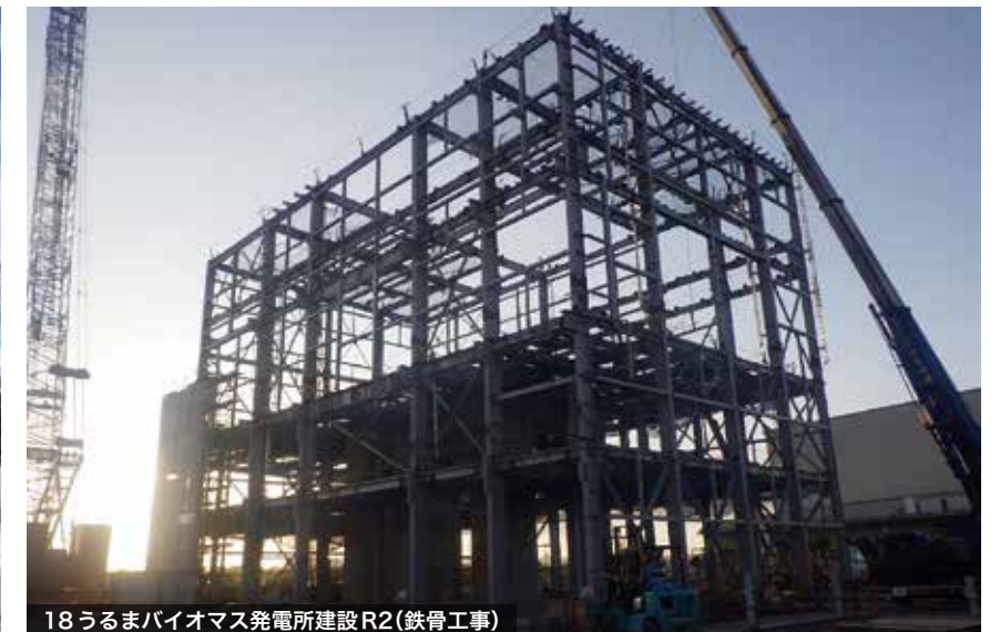
18うるまバイオマス発電所建設R2(鉄骨工事)
