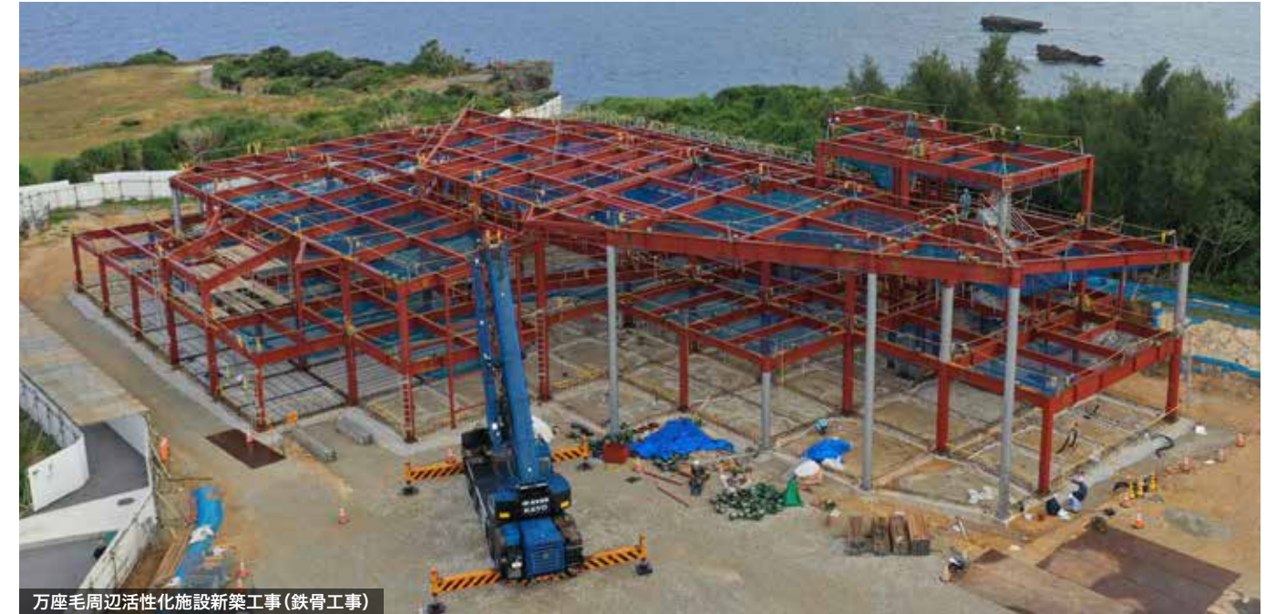
万座毛周辺活性化施設新築工事(鉄骨工事)
