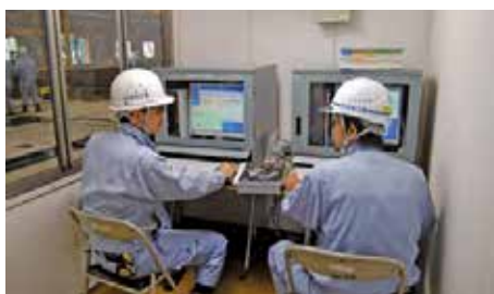
操作は別室の入力画面にてデータを作成
