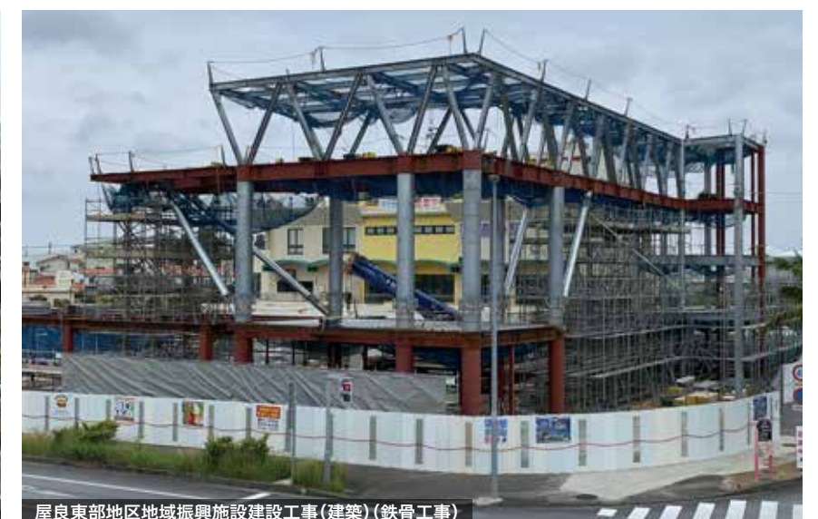
屋良東部地区地域振興施設建設工事(建築)(鉄骨工事)
