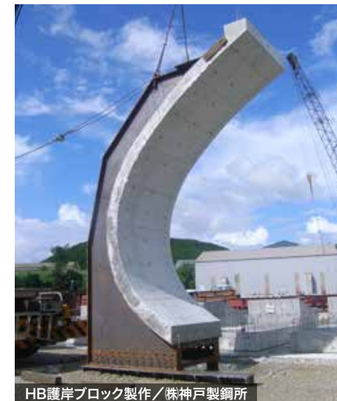
HB護岸ブロック製作/株神戸製鋼所
