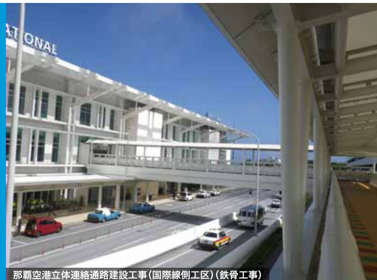
那覇空港立体連絡通路建設工事(国際線側工区)(鉄骨工事)
