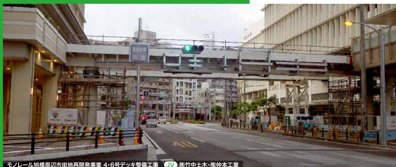
モノレール旭橋周辺市街地再開発事業 4・6号デッキ整備工事 JV 株竹中土木・株仲本工業
