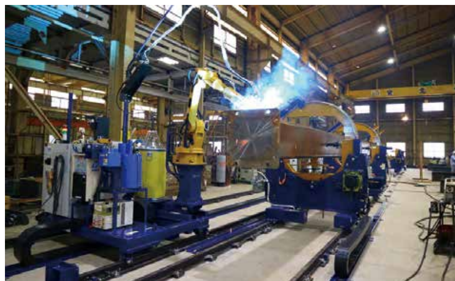
鉄骨柱大組立“2 アーク・2 ポジ”溶接ロボットシステム
