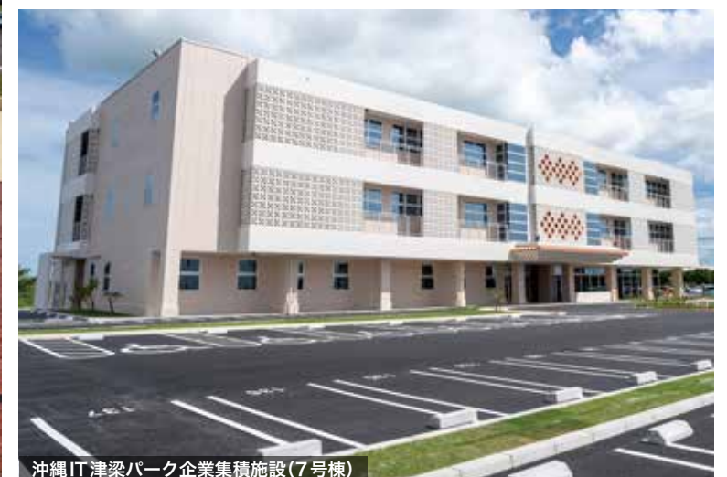
沖縄IT津梁パーク企業集積施設(7号棟)
