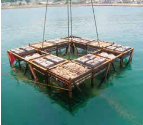
鉄骨スラグを組み込んだ「藻場礁」を水深6メートルに沈設し、モニタリング調査を行う。
