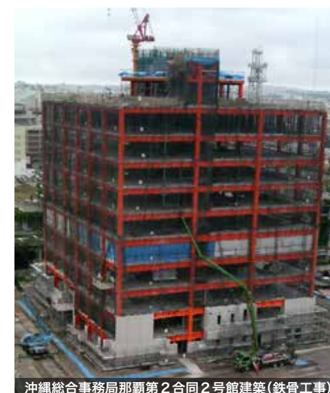
沖縄総合事務局那覇第2合同2号館建築(鉄骨工事)
