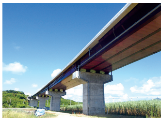
⑩ 下田原大橋
